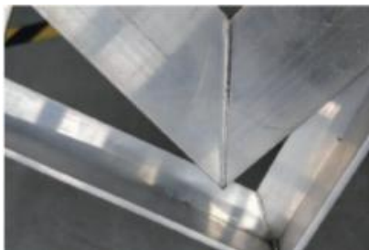
Saldadura continua en acero inoxidable
